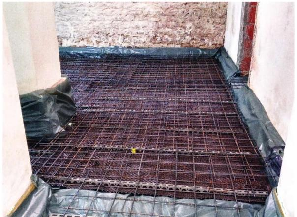
Abb. 12: Neuaufbau des Bodens (eisenbewehrter Estrich, Fliesen).
