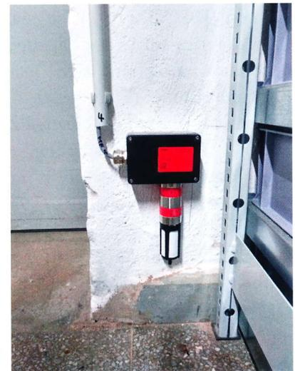
Abb. 5: Detektor für gasförmiges Ethanol in Bodennähe.
