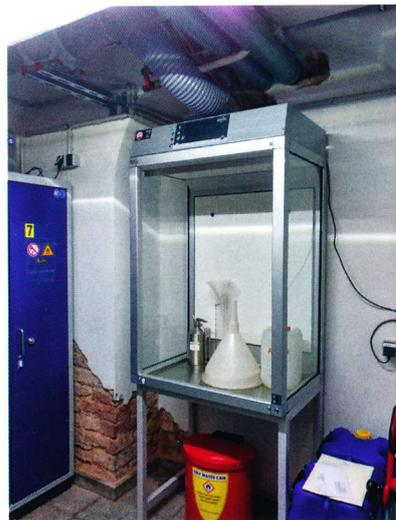
Abb. 4: Gefahrstoffarbeitsplatz mit Abluft zum Umfüllen von Alkoholgläsern.
