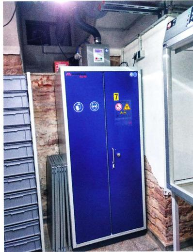
Abb. 2: Abfüllanlage für Ethanol, links: geschlossener Fassschrank mit Abluft, rechts: geöffneter Schrank mit Vorratsfass, Fasspumpe und Transportbehälter
