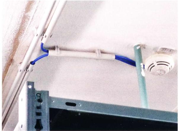
Abb. 11: Explosionsgeschützter Rauchmelder.
