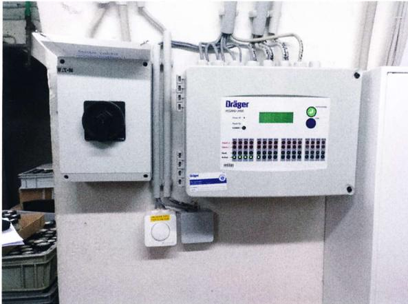
Abb. 8: Steuerungsanlage zur Gasüberwachung.
