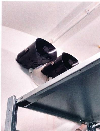
links: Abb. 6: Warnblinklichtanlage bei erhöhter Gaskonzentration.
